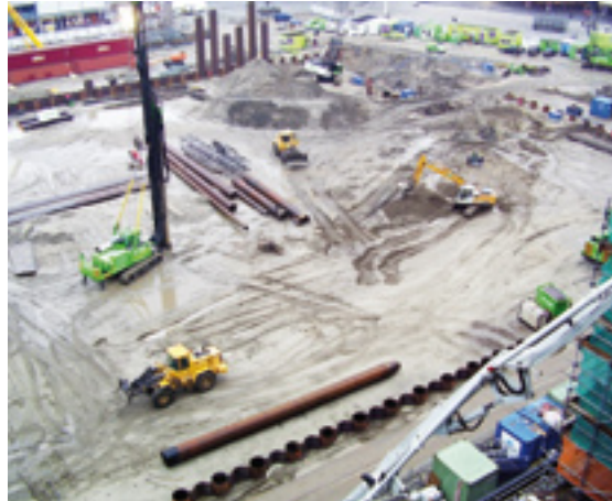
Werkzaamheden op het bouwterrein
